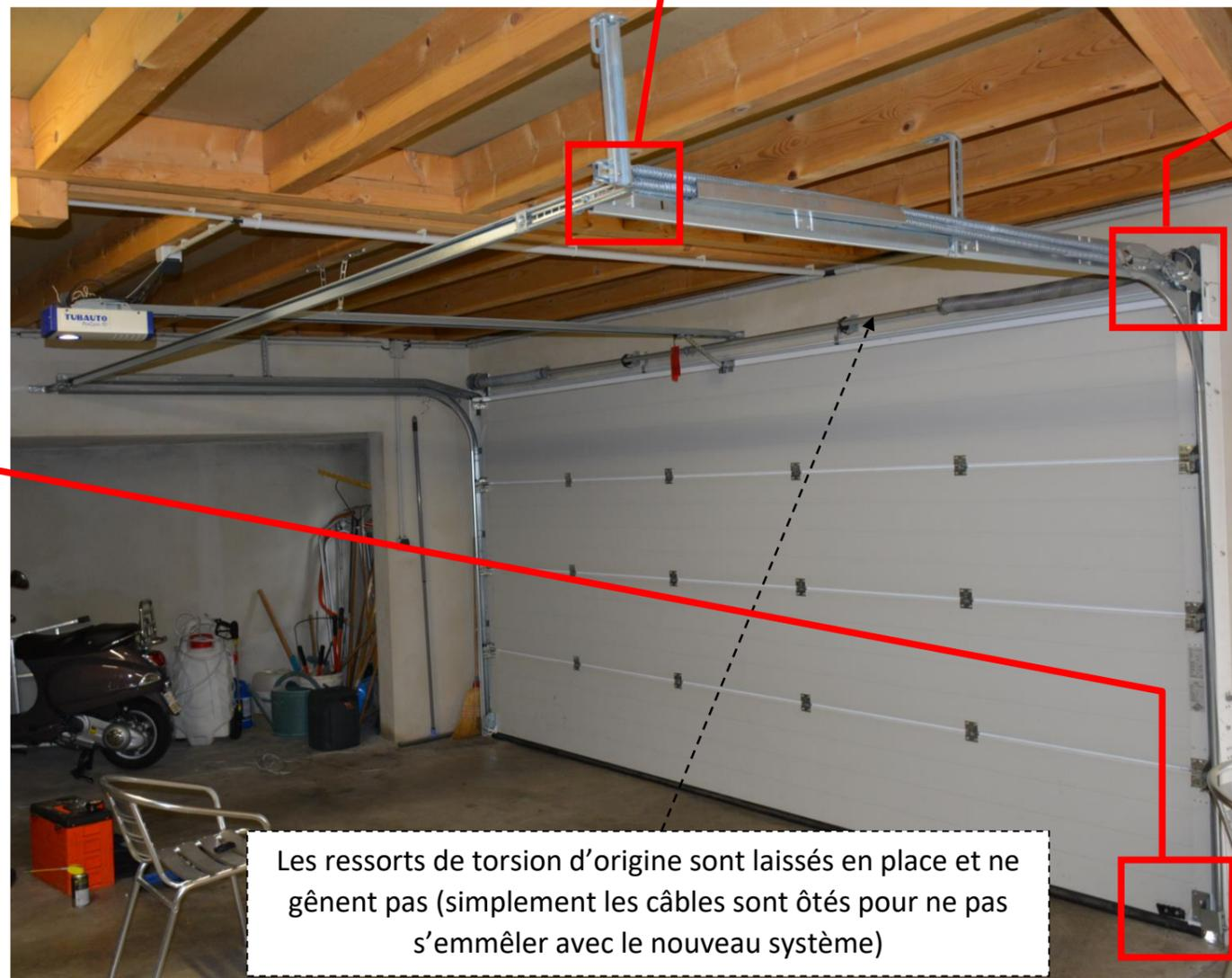
Les ressorts de torsion d'origine sont laissés en place et ne gênent pas (simplement les câbles sont ôtés pour ne pas s'emmêler avec le nouveau système)
