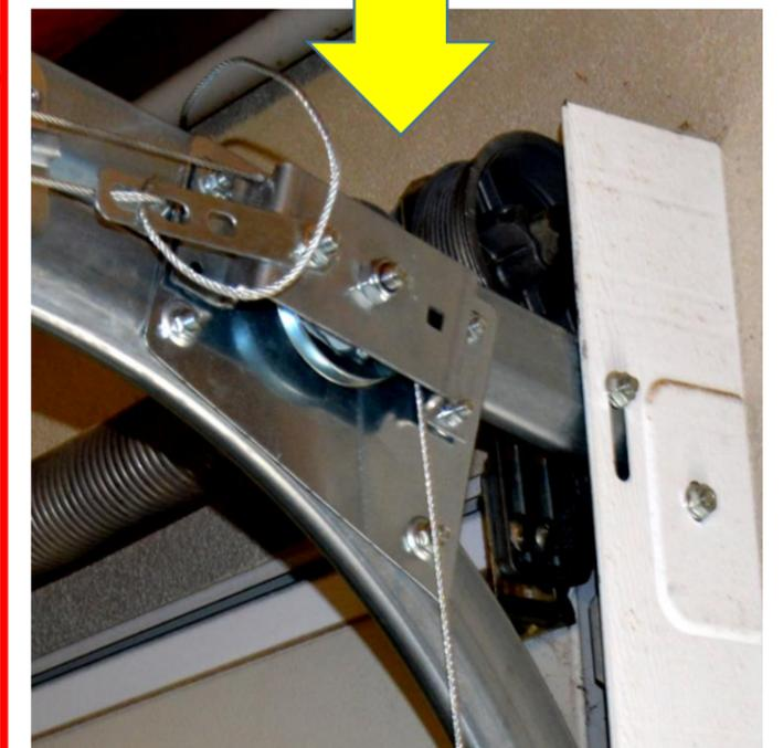
Fixation platine support sur la courbe avant pour mise en place poulie de renvoi
