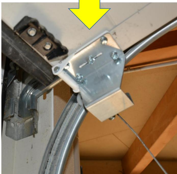
Remplacement du support d'origine par le support bas pour câble déporté (à faire porte ouverte et bloquée)
