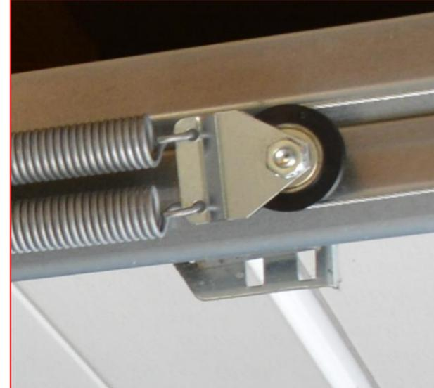
Perçage pour boulonnage du sabot à l'arrière des rails pour accrocher les ressorts. (goulotte de protection facultative pour protéger les ressorts)
