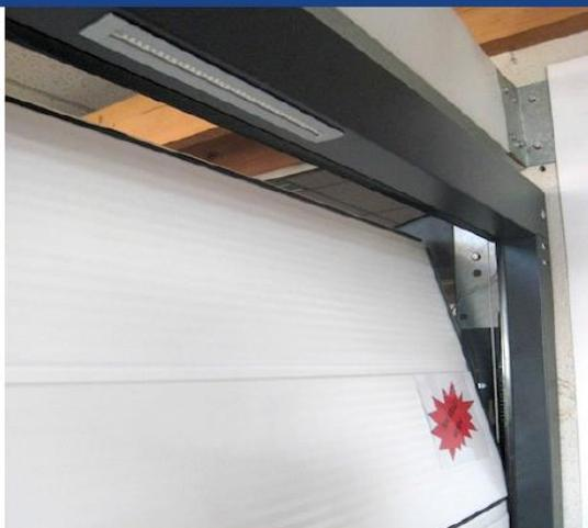
Position aération : Le moteur bloque la porte au sol, mais avec la section supérieure entr'ouverte.
